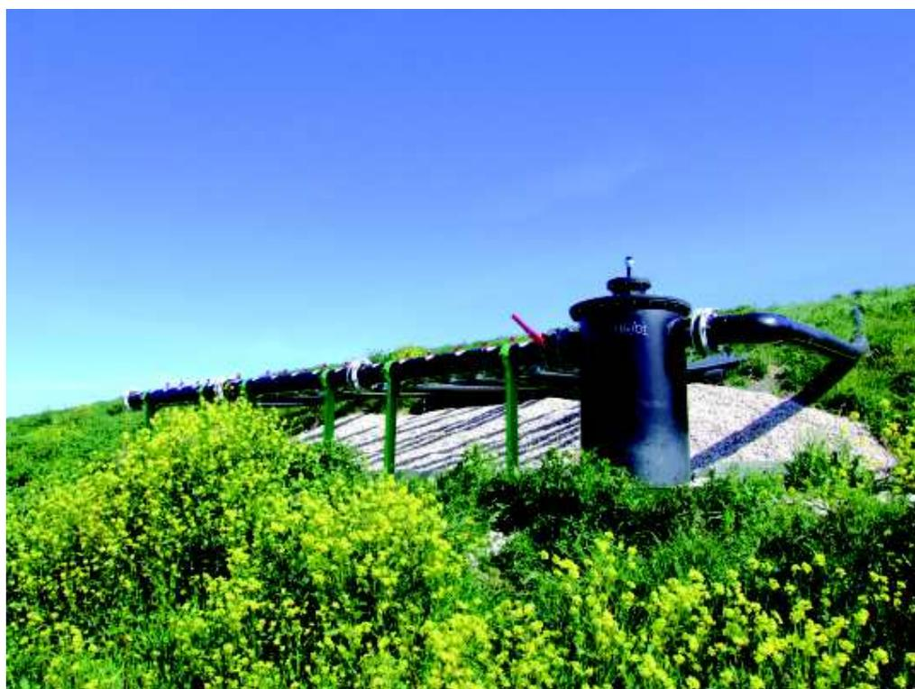
**Fig.10** rete di captazione del biogas inviato a produzione di energia elettrica
