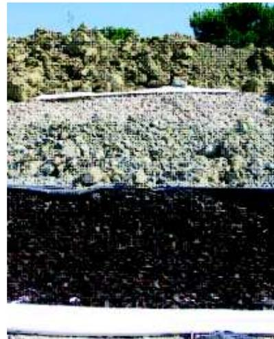
**Fig.19** il riutilizzo dei pneumatici tritati per la ricopertura finale consentono il risparmio di migliaia di tonnellate di inerti da cava
